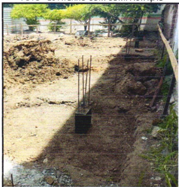
FOTO - 10 ATERRO COM COMPACTAÇÃO
